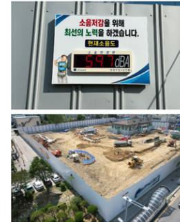
건설현장 인근 주민들의 소음·진동 피해를 선제적으로 예방하기 위해 파일 향타 및 알폼 해체 시 소음방지 판넬과 이동식 방음벽을 설치하여 법적 기준보다 강화된 기준으로 소음 저감을 위해 노력하고 있습니다. 건설현장에서 발생하는 진동에 의한 지역의 피해를 예방하기 위하여 진동, 균열을 사전에 조사하고, 외부 전문기관을 통해 주기적으로 점검하고 있으며 현장내 소음/진동 측정기를 설치하여 모니터링하며 실시간으로 공개하고 있습니다. 도심지내 소음진동 저감을 위해 저소음/저진동 공법을 사전에 마련하여, 가설 방음벽과 부분 투명 방음벽 및 음측 창호 차음 성능을 보강하고 있습니다. 암석 굴착 공사에서는 에어돔 방음시설을 설치하여 소음 저감을 위해 노력하고 있습니다. 또한 현장에서 민원발생시, 신속하게 대응하여 피해 확산을 방지하고 있습니다.
