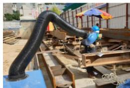
계룡건설은 건설과정에서 발생하는 비산먼지 등 각 현장에서 발생하는 대기오염 물질을 현장 특성에 맞는 방진대책을 수립하여 현장의 비산먼지 발생 저감노력을 하고 있습니다. 민원 우려현장에 매일 2회 이상 살수 차량을 이용하여 현장 내의 물을 뿌리고, 전 현장 진출입로에 세륜 장치 및 고압살수기를 설치하여 차량 진출입시 대기오염물질을 제거 후 반출하고 있으며 추가적으로 현장별 특성에 맞는 다양한 공법(준설현장 조사료 살포, 대규모 토목공정 공중 광역살수, 철거현장 방진살수기 운영, 배수로사면 식생매트 설치, 그라인더 및 용접시 집진기사용 등)을 활용하여 대기오염 발생 저감에 힘쓰고 있습니다.
